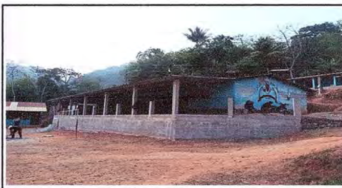
Foto 6: Muro perimetral vista general terminado
