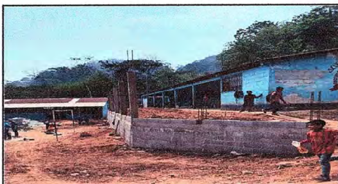
Foto 3: Muro perimetral lateral del muro terminado
