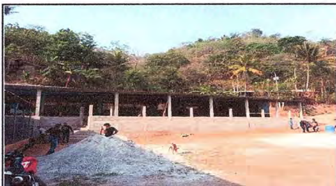
Foto 4: Muro perimetral parte de enfrente culminado
