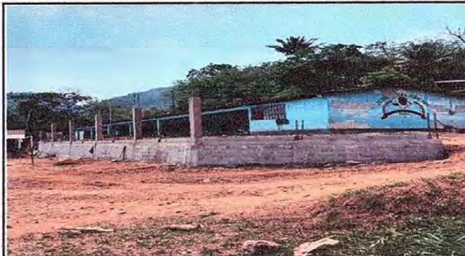
Foto 2: Muro perimetral parte de enfrente
