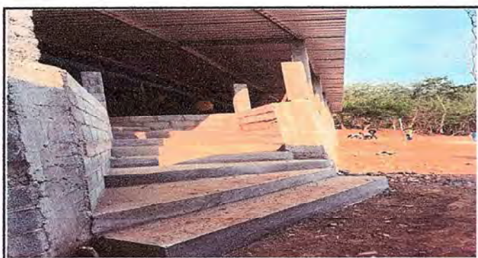
Foto 5: Muro perimetral culminación de gradas
